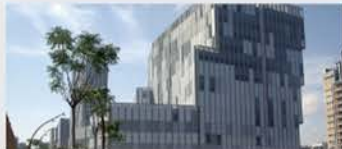
UTG del Campus Diagonal-Besòs
