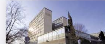
UTG de l'Àmbit d'Enginyeria Industrial de Barcelona
